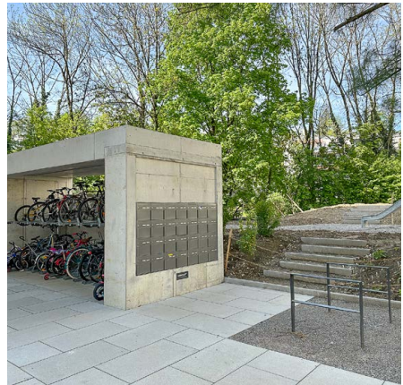
Velounterstand und Briefkastenanlage
